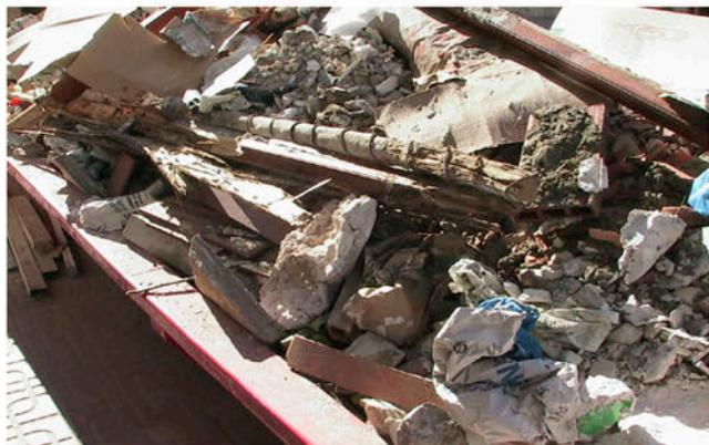
No depositar maderas afectadas por termitas con otro tipo de escombros (como se observa en la fotografía). Se depositarán en contenedores metálicos que la administración gestionará para su eliminación
