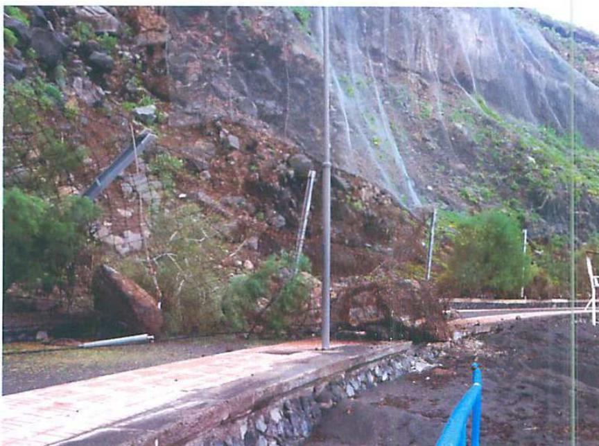
**Figura 2.** Roturas en el pavimento y destrozado de la barrera dinámica instalada a lo largo de este tramo del paseo, producidos por los materiales desprendidos.
