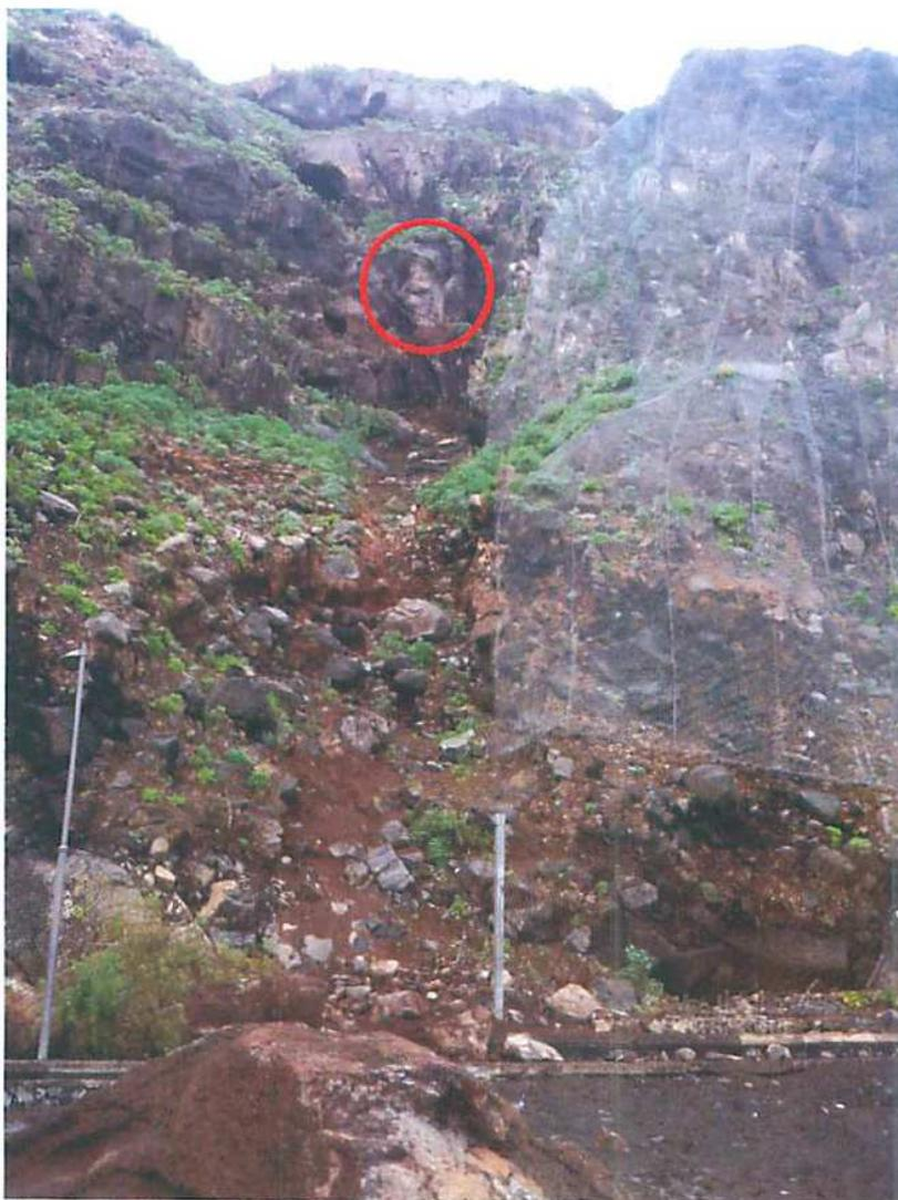
**Figura 3.** Foco del último desprendimiento (circulo rojo) localizado en un paquete de coladas basálticas, que se apoya sobre un piedemonte constituido por depósitos coluviales.
